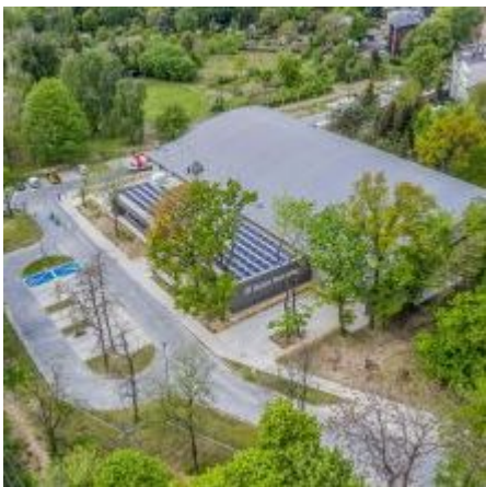
• Ul na dachu Basenu Burowiec
