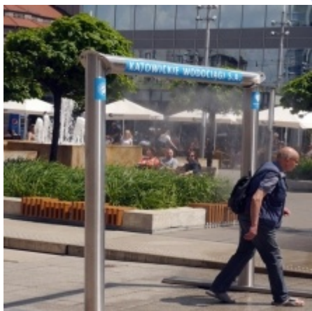
Kurtyny wodne w Katowicach
